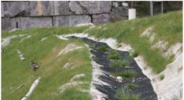
Esempio di messa in opera di un canale superficiale di gronda da realizzare a mezzacosta lungo il versante per intercettare le acque di dilavamento
