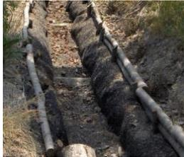
**4** Si consiglia di abbinare una biostuoia biodegradabile sui lati della canaletta, al fine di contenere i fenomeni erosivi, prima della crescita della vegetazione. Per applicazioni su forti pendenze, inserire longitudinalmente i tronchi rompi-tratta per ridurre le velocità dell'acqua e ricordarsi di predisporre adeguate opere di raccolta, a valle.
