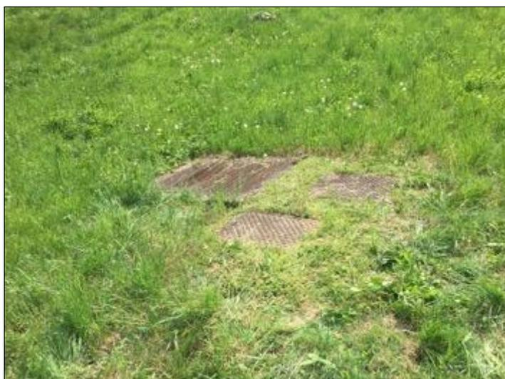
Griglia presente lungo il corso d'acqua BG194-19 per la raccolta delle acque meteoriche di dilavamento dei pendii attorno al Centro Vivace
