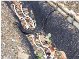
**2** Sormontare i teli in senso longitudinale, a tegola, per almeno 20 cm e fissare con n° 4 picchetti (vedi nota 1)
